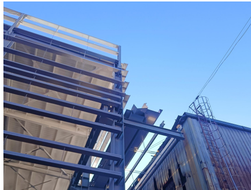
吊运至房顶的雨水槽
